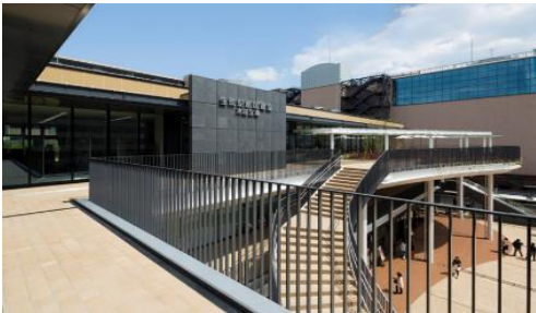
生駒駅前図書室 木田文庫
